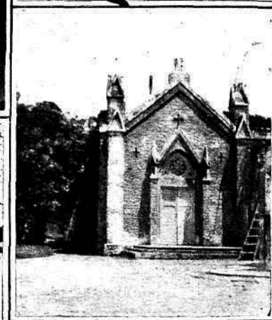
Vista exterior de la capilla
